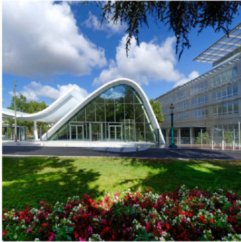
CRÉDIT AGRICOLE - CHANTIER ÉOLE Montrouge, France
